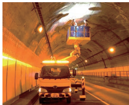
図1 点検車のデッキでトンネル壁面を検査する
