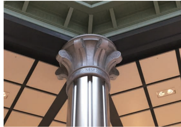
東京駅丸の内南口駅舎の柱に刻まれたローマ数字MMXII（写真中央）
