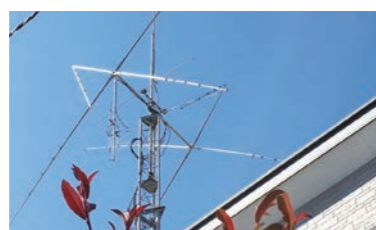
無残に折れた大型アンテナ (本来は二重のX字型)
